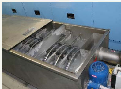
洗濯排水熱交換器の導入
