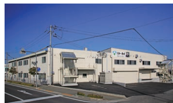
外観(四国メンテナンスセンター)
