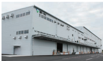
外観(埼玉メンテナンスセンター)
