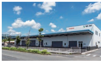
外観(九州メンテナンスセンター)
