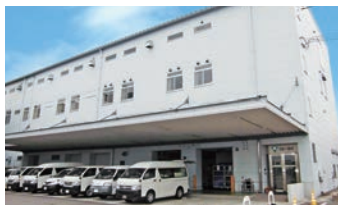
外観(羽島メンテナンスセンター)
