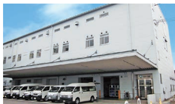
外観(羽島メンテナンスセンター)
