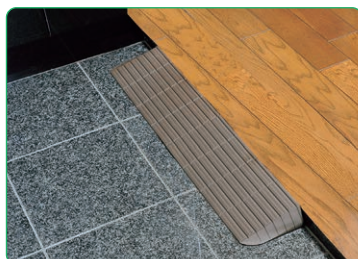
玄関(あがりかまち)の段差
