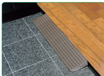
玄関(あがりかまち)の段差
