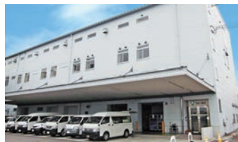
外観(羽島メンテナンスセンター)
