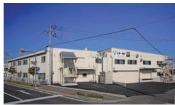
外観(四国メンテナンスセンター)
