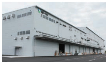
外観(埼玉メンテナンスセンター)
