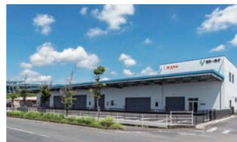
外観(九州メンテナンスセンター)
