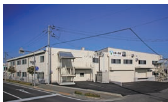
外観(四国メンテナンスセンター)
