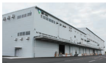
外観(埼玉メンテナンスセンター)
