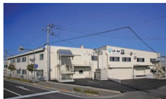
外観(四国メンテナンスセンター)
