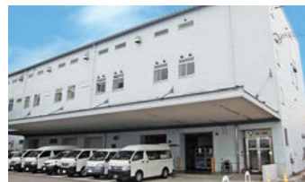
外観(羽島メンテナンスセンター)
