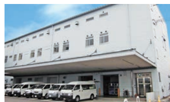
外観(羽島メンテナンスセンター)
