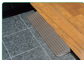
玄関(あがりかまち)の段差
