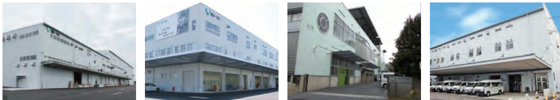
外観(埼玉メンテナンスセンター) 外観(千葉メンテナンスセンター) 外観(横浜南メンテナンスセンター) 外観(羽島メンテナンスセンター)
