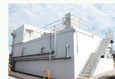
排水処理施設
