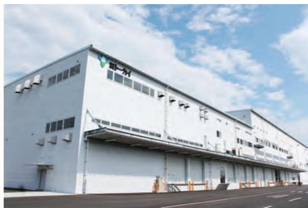
2023年10月には、関東エリアの新たな基幹工場となる埼玉工場を新設。
