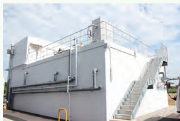
排水処理施設
