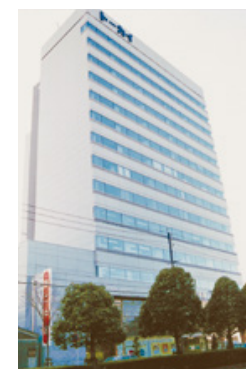
トーカイ本社ビル
