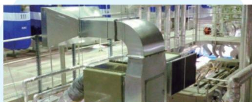
「エネルギー管理システム」の導入により、使用電力量のピークカットや節電対策を効果的に実施。また、電気を使わない「井水式ユニットクーラー」によって使用電力を大幅削減するとともに、温度上昇した井戸水は洗濯水に活用してエネルギー使用量の削減も図っています。
